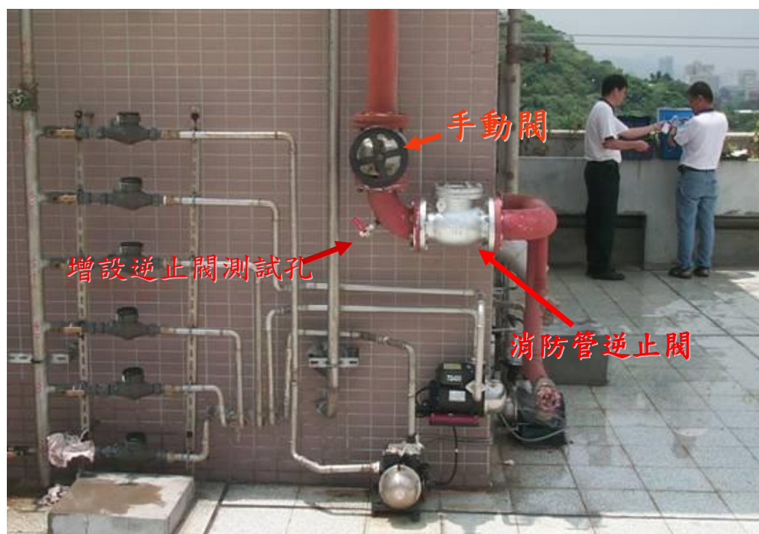
圖 3.2 消防管線附屬設備（資料來源：臺北自來水事業處）
