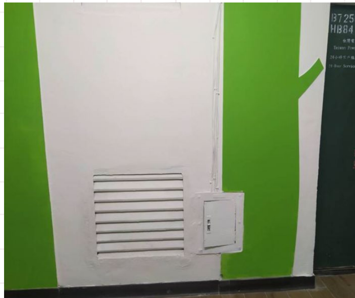
修補並粉刷破損處
