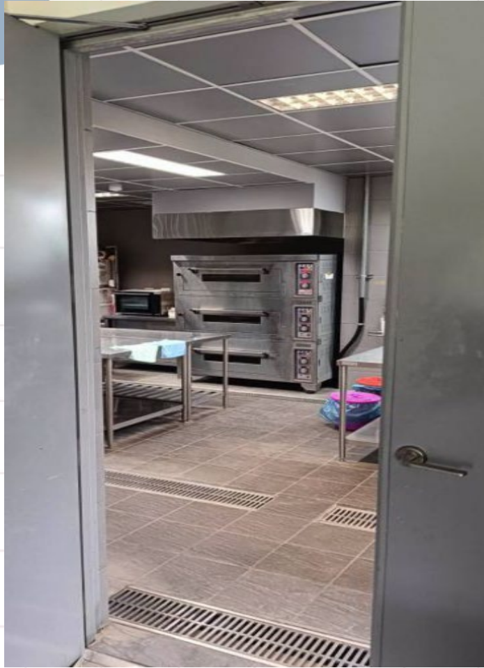
對外門口缺紗門設備
